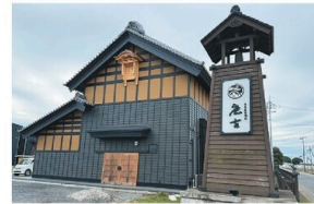
和モダンで統一された本社や倉庫
